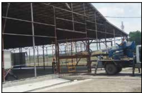
Идет ремонт складских помещений для хранения семян
